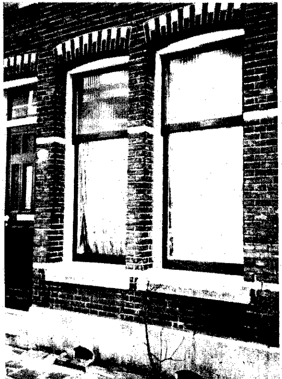
Verticale schuiframen uit de vorige eeuw hebben een typerend kleurgebruik. Door het diepliggende raam ontstaat een levendige schaduwwerking. Foto: E. de Jonge
