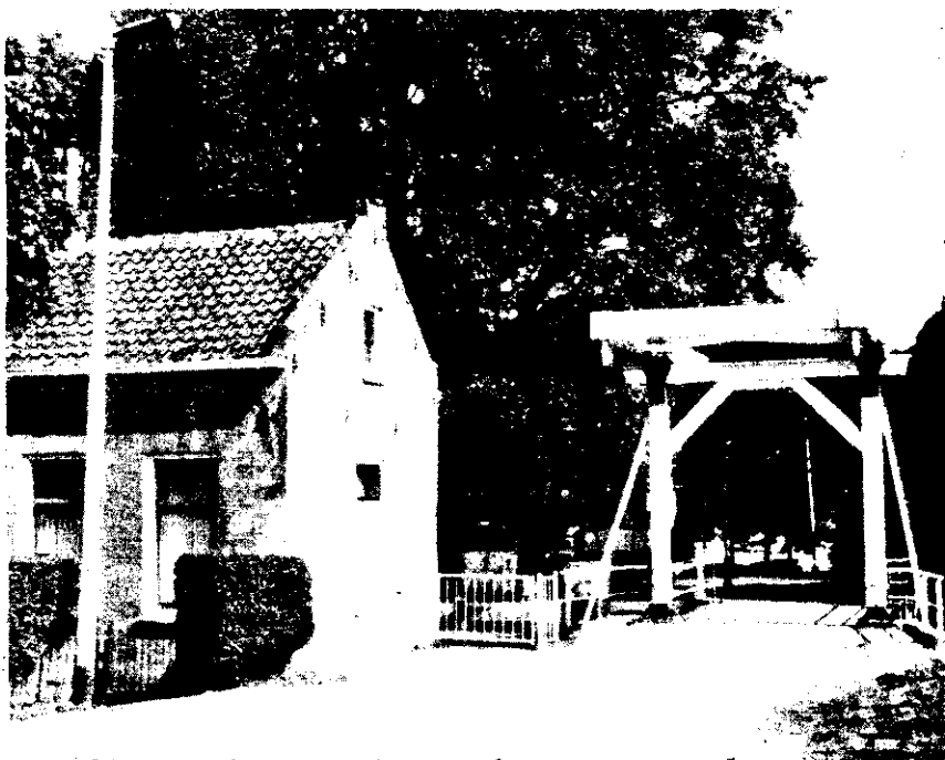
Sluiswachterswoning en brug over verlaat
