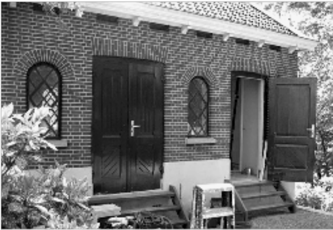
Anno begin mei worden nog afrondende werkzaamheden aan het baarhuisje verricht.
