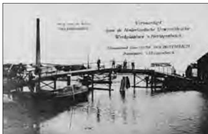
Ook Hillegersberg paste zich in het begin van de twintigste eeuw aan de nieuwe tijd aan. Bruggen en oeververbindingen – zij het bescheiden – werden derhalve hoogst noodzakelijk gevonden, zoals deze smalle brug in 1923 gebouwd op initiatief van de bewoners van de Linker-Rottekade.
