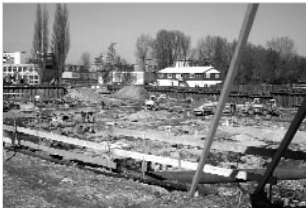
De bouwput voor de nieuwe AH.
